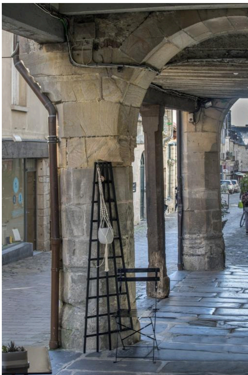
Vue sous le porche de l'édifice en pan de bois.
