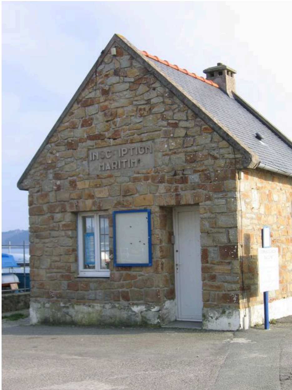
Vue générale de l'ancien bureau du garde maritime
