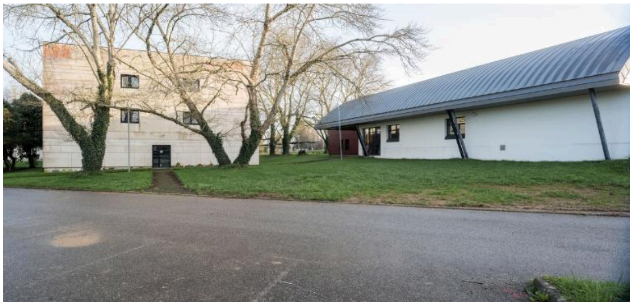
Façades sud-ouest de l'internat et nord-ouest du service de restauration.
