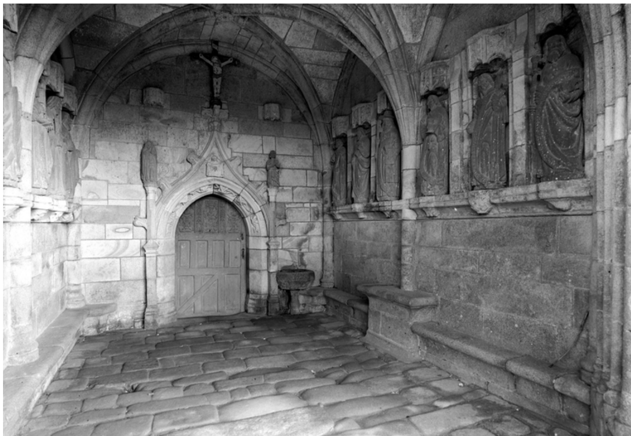
Vue diagonale de l'intérieur du porche vers le nord est
