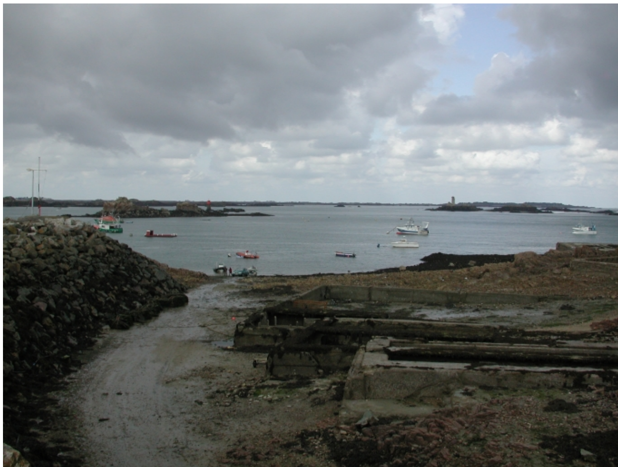
Vue du chemin bétonné qui conduit aux viviers en ciment en contre-bas des enrochements à l'est du port
