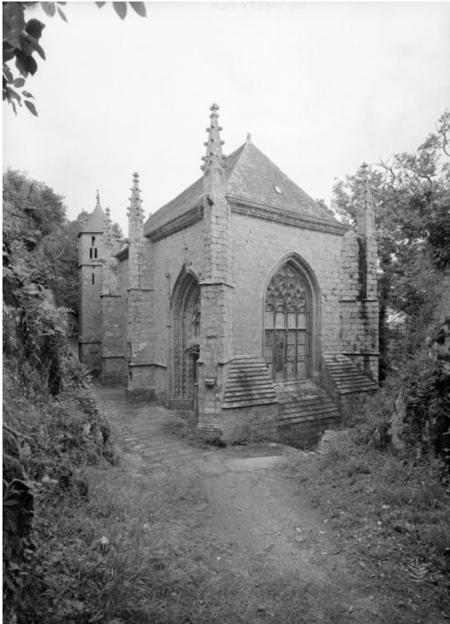
Vue générale prise du sud-ouest.
