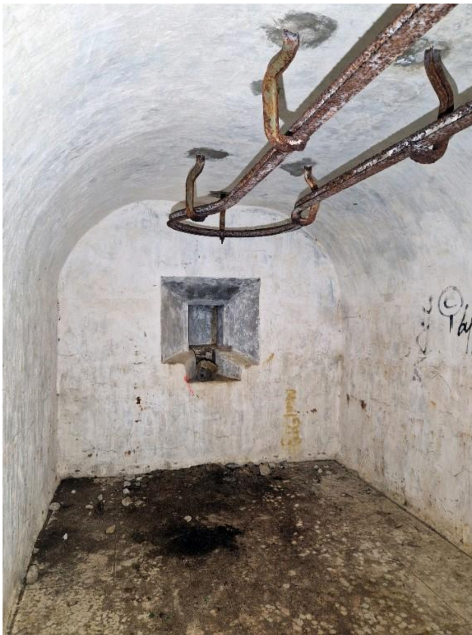
Vue intérieure du magasin à munitions : extrémité ouest avec créneau à lampe, fixations et rail pour la manutention des obus via un palan
