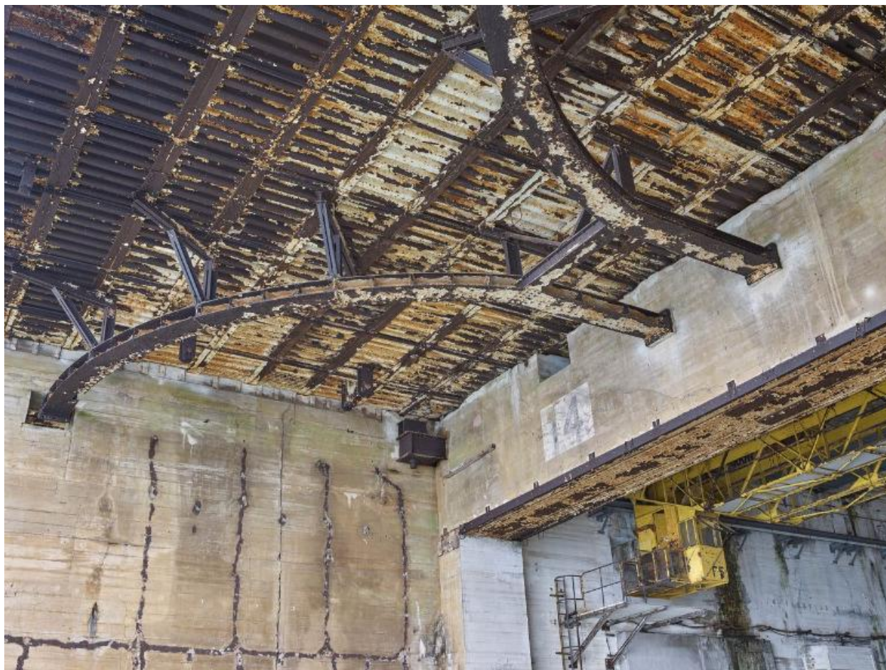
Vue de l'entrée de l'alvéole G (n° 13 et 14) : supports de fixation de la porte haute
