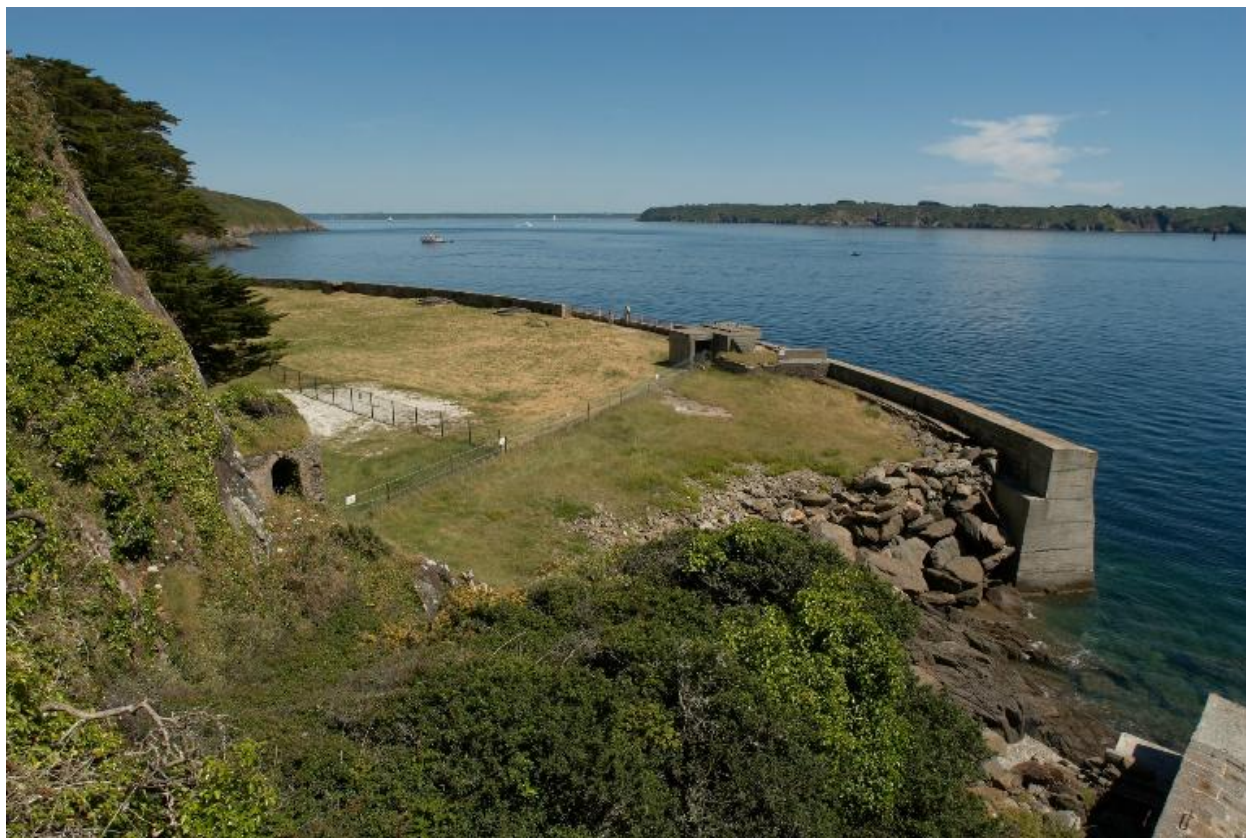
Plouzané : vue du fort du Mengant, abri
