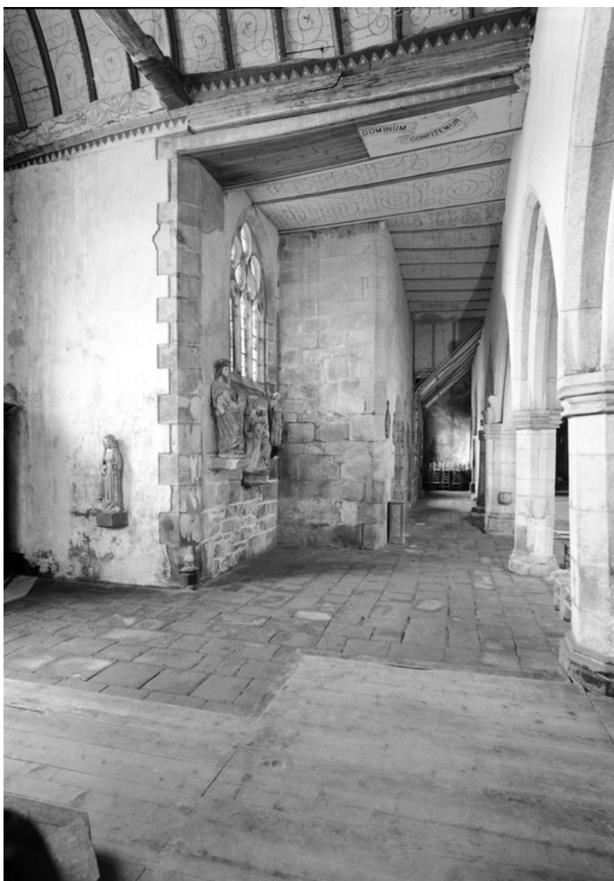
Raccordement du bras sud du transept avec le mur du bas-côté sud
