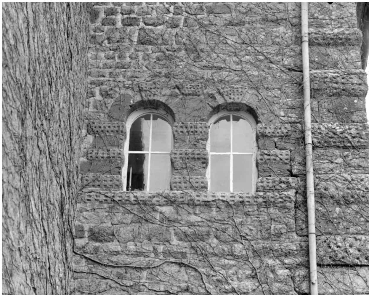
Pavillon est : baies jumelées, vue de détail.
