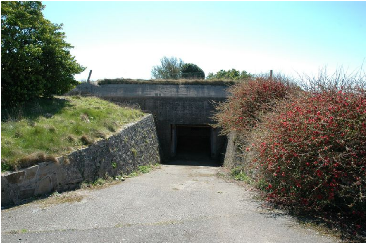
Vue de l'ensemble fortifié de la pointe du Renard : abri de type V 256 pour machine (identique à celui de Kervélédan sur la commune de Ploumoguier : R 311 / Donau)
