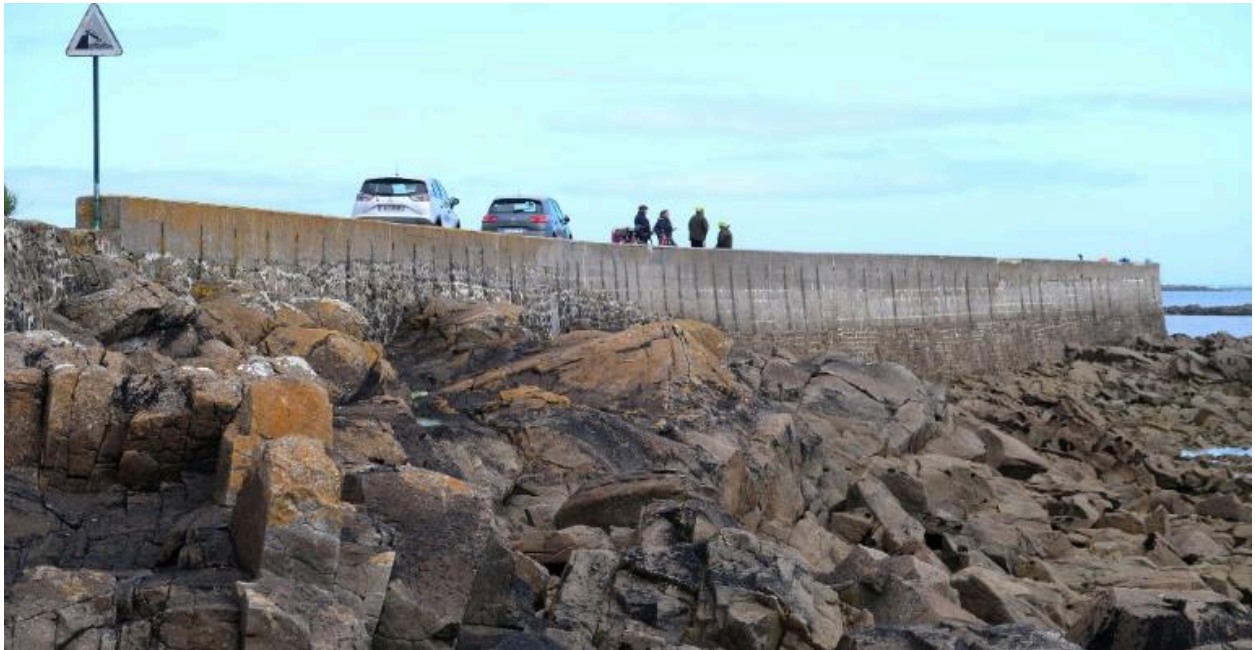
Jetée de Pen -Ar-Vil : maçonnerie du mur côté Est prenant appui sur les rochers
