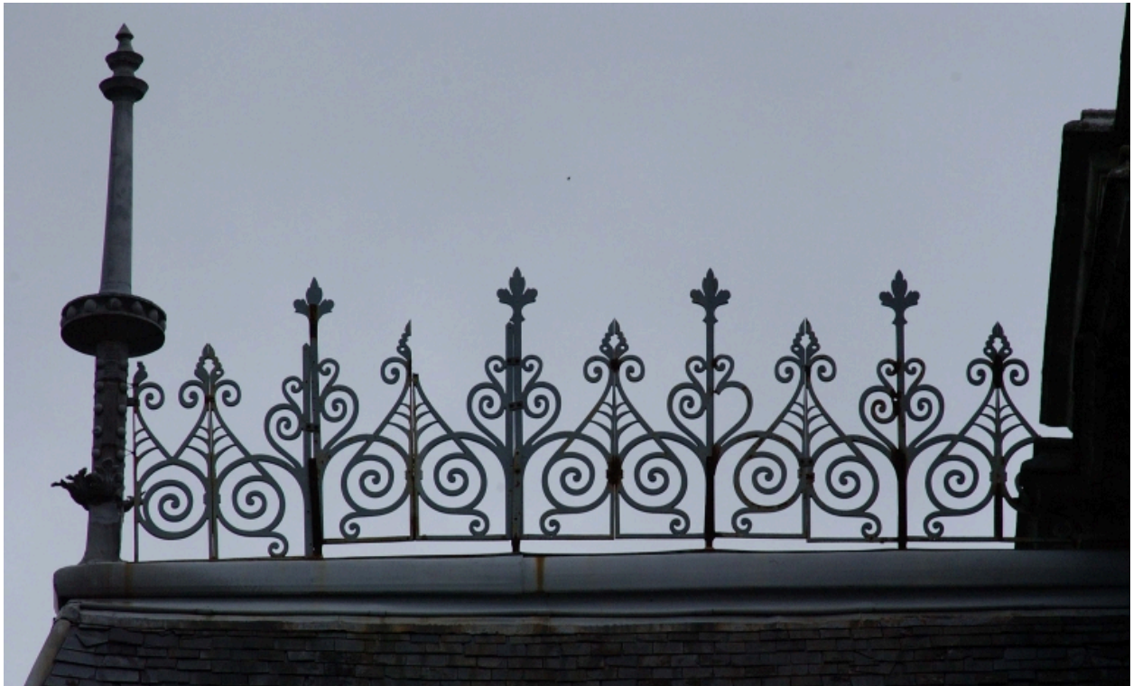
Faîtage de toiture
