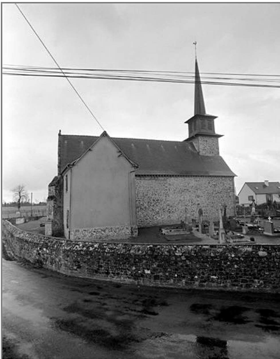
Élévation Nord : vue générale
