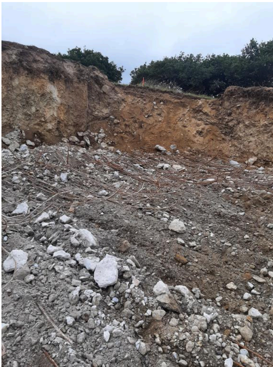
Vue de la déconstruction (1er octobre 2022). Au sol : fers et granulat de béton
