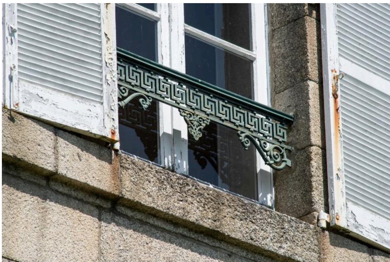
Détail de la ferronnerie de la fenêtre
