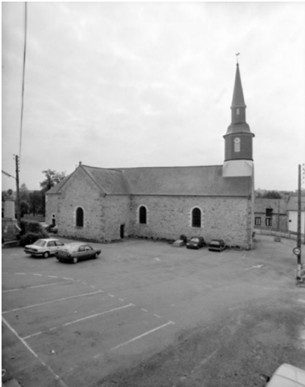
Élévation Nord : vue générale
