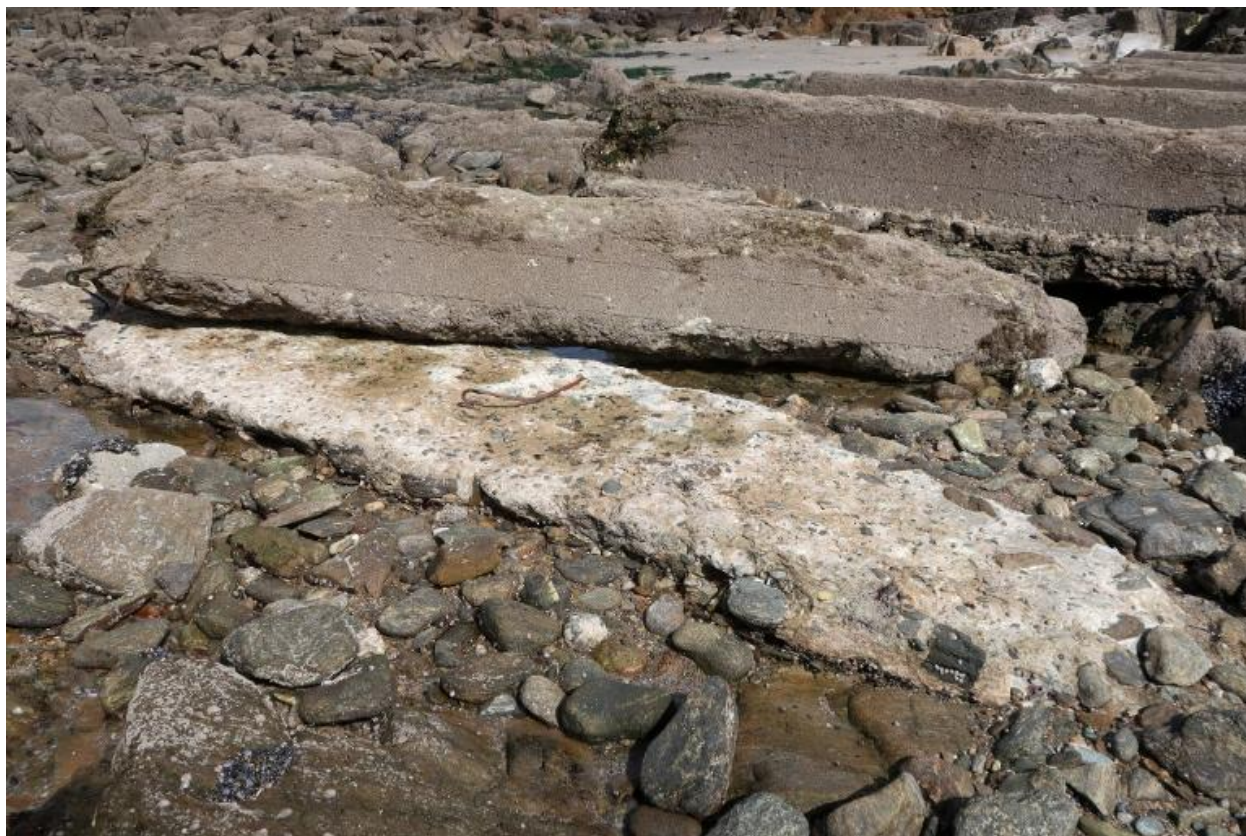
Vue des vestiges de la passerelle
