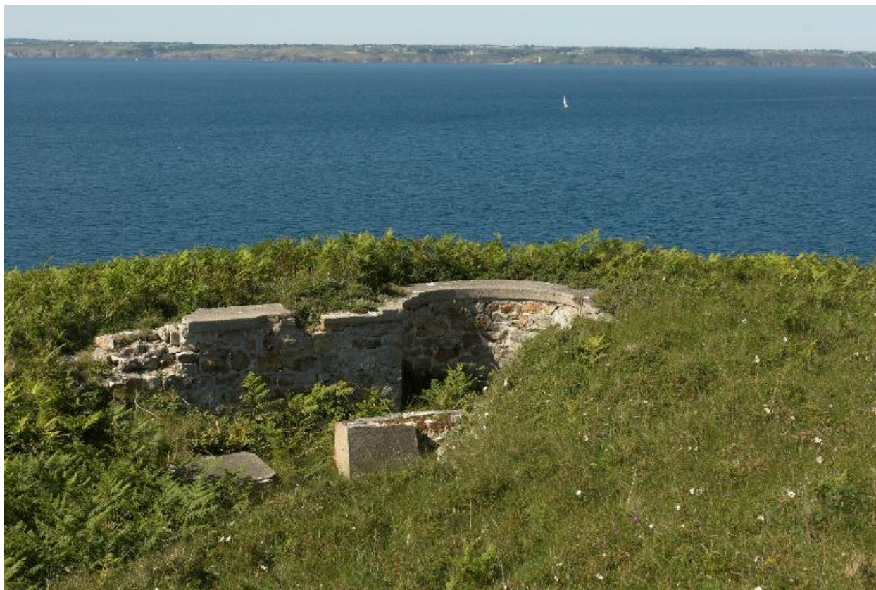
Camaret, pointe du Toulinguet : batterie de côte, poste de direction de tir
