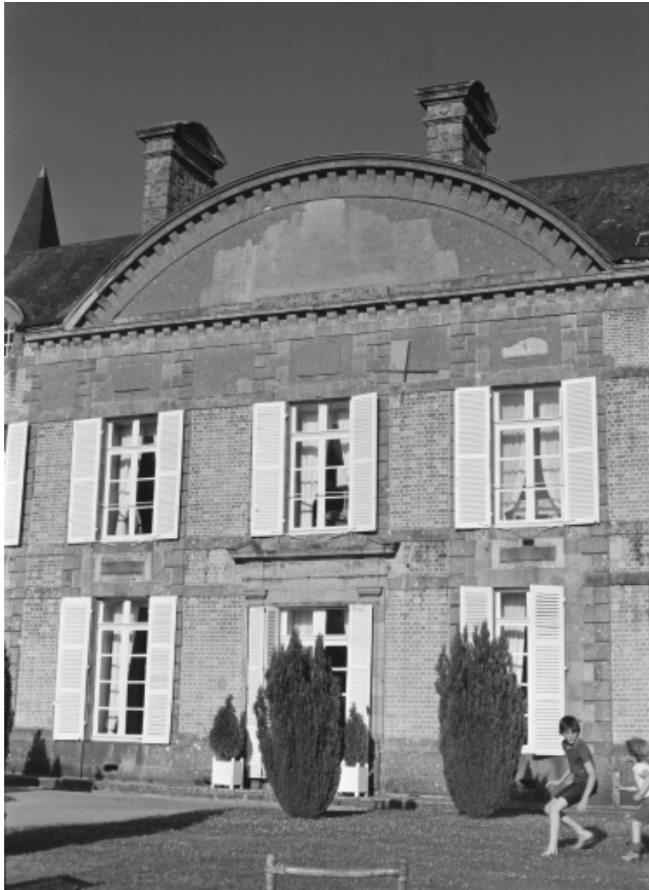
Partie centrale, façade postérieure
