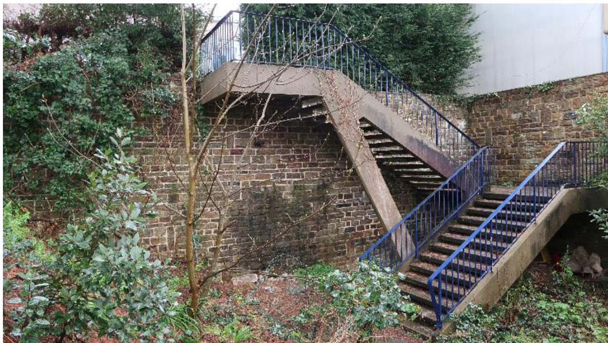
Escalier d'accès aux logements de fonction situés au sud de la parcelle.
