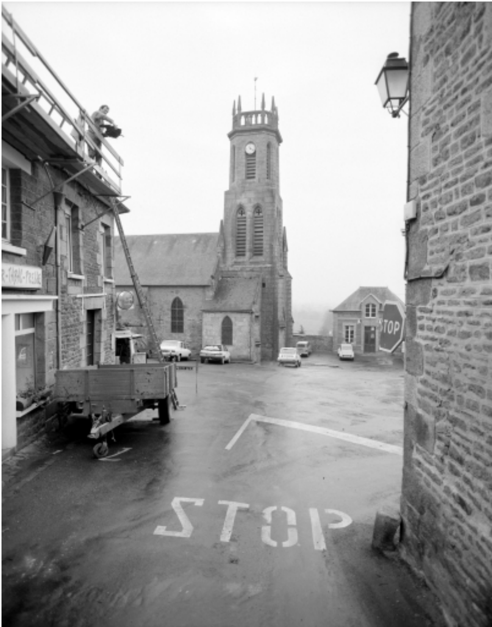
Elévation Nord, partie Ouest : vue générale
