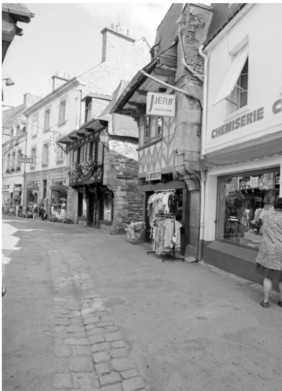
13-15 et 17 rue du fil, vue générale.
