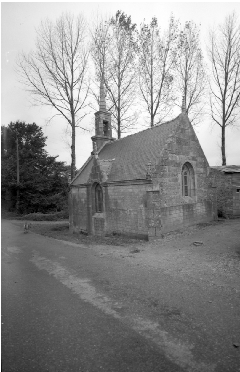
Vue générale de l'angle sud-est
