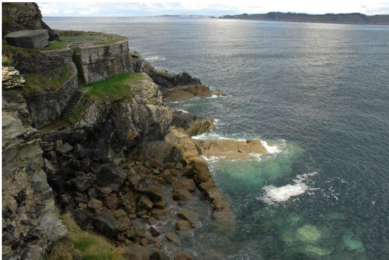
Vue de l'escalier d'accès depuis l'est (état en 2005)
