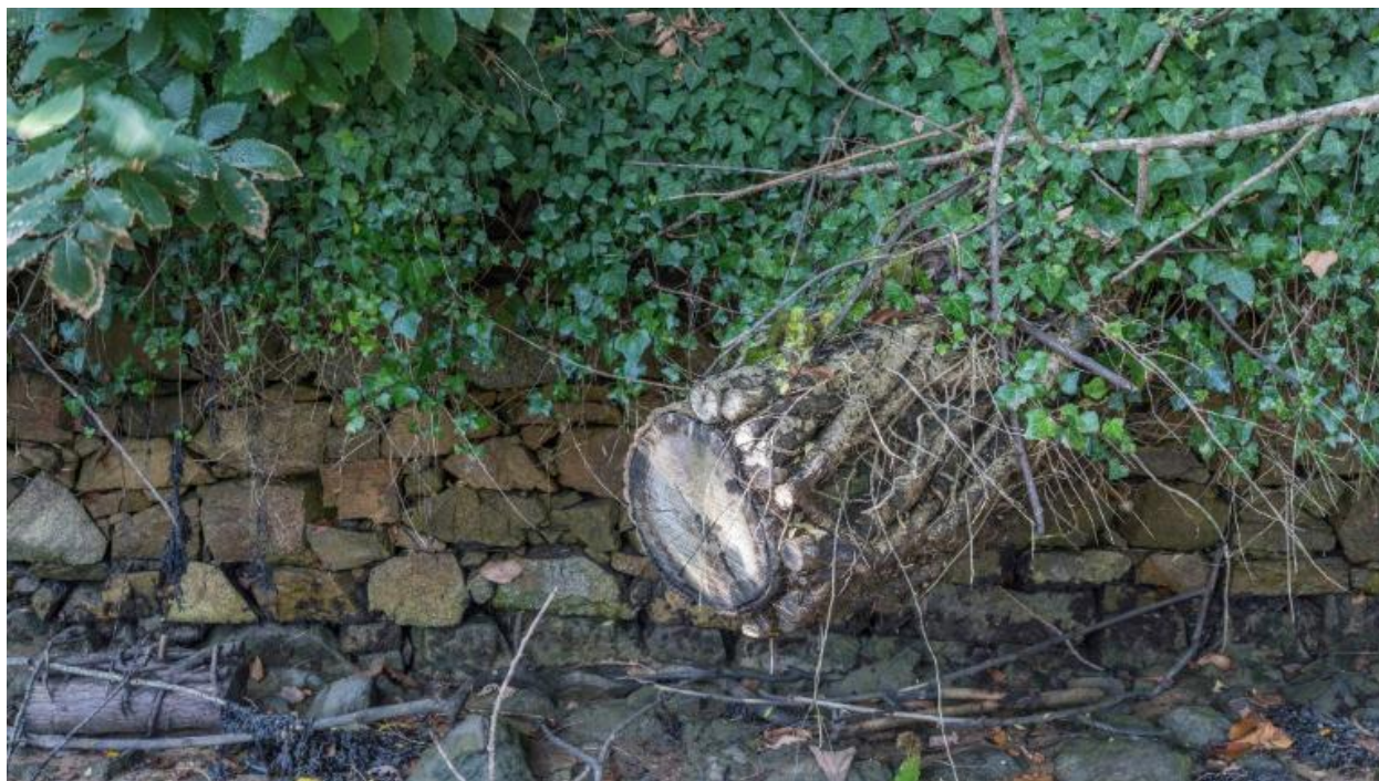
Vue d'un tronc d'arbre provenant des terres retenues par un mur de soutènement, dans la petite anse du Kerautret
