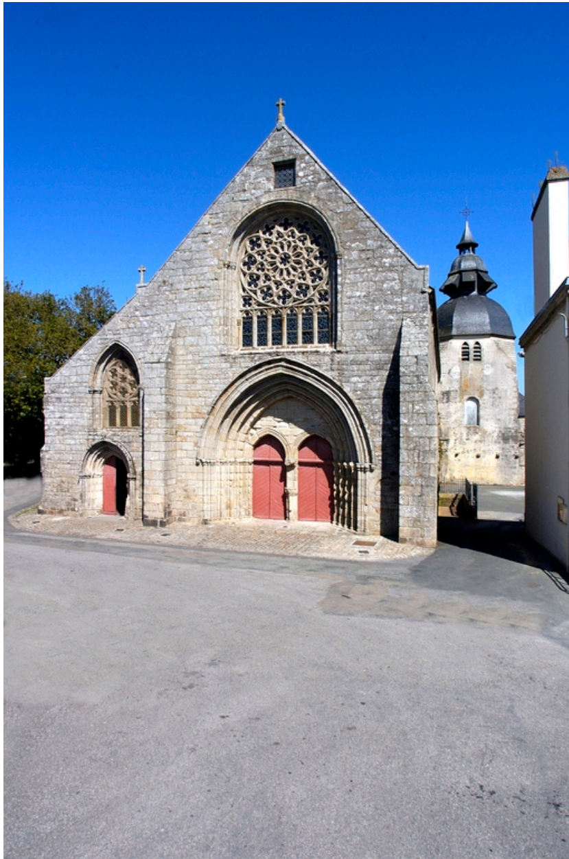
Vue générale de la façade ouest
