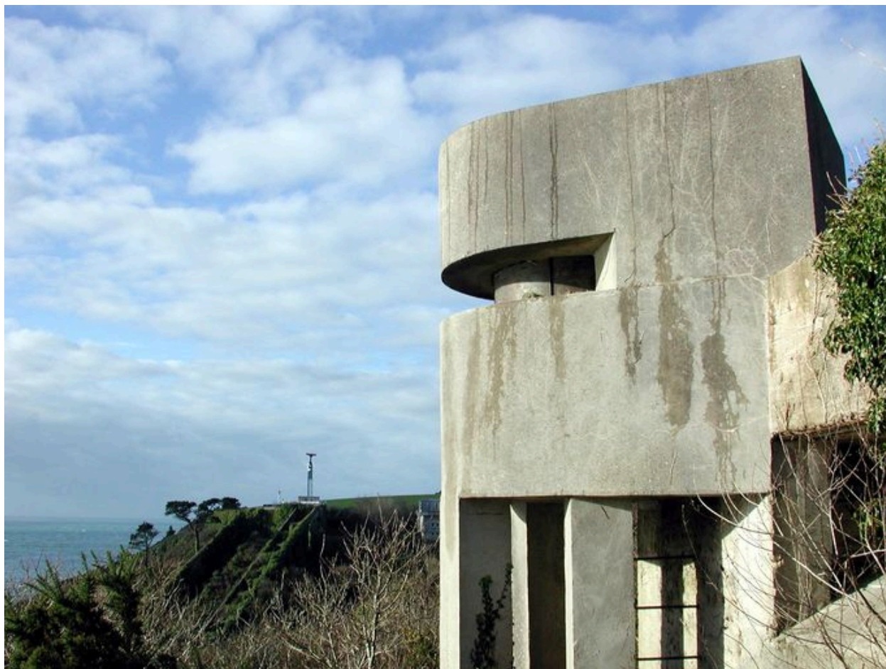
Vue de l'un des postes d'observation et de télémétrie : bâtiment n° 1 (état en 2007)
