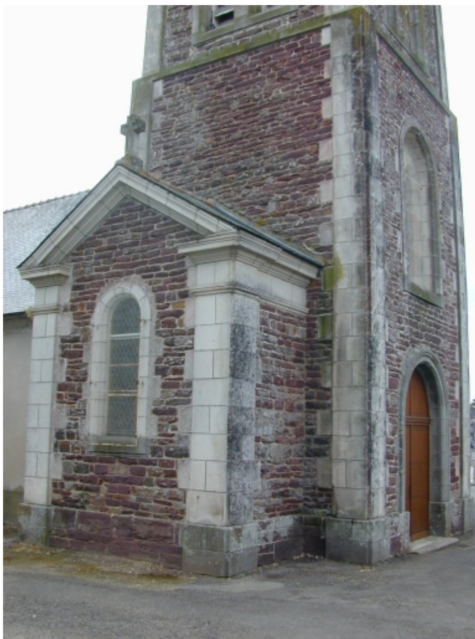
Vue partielle nord-ouest
