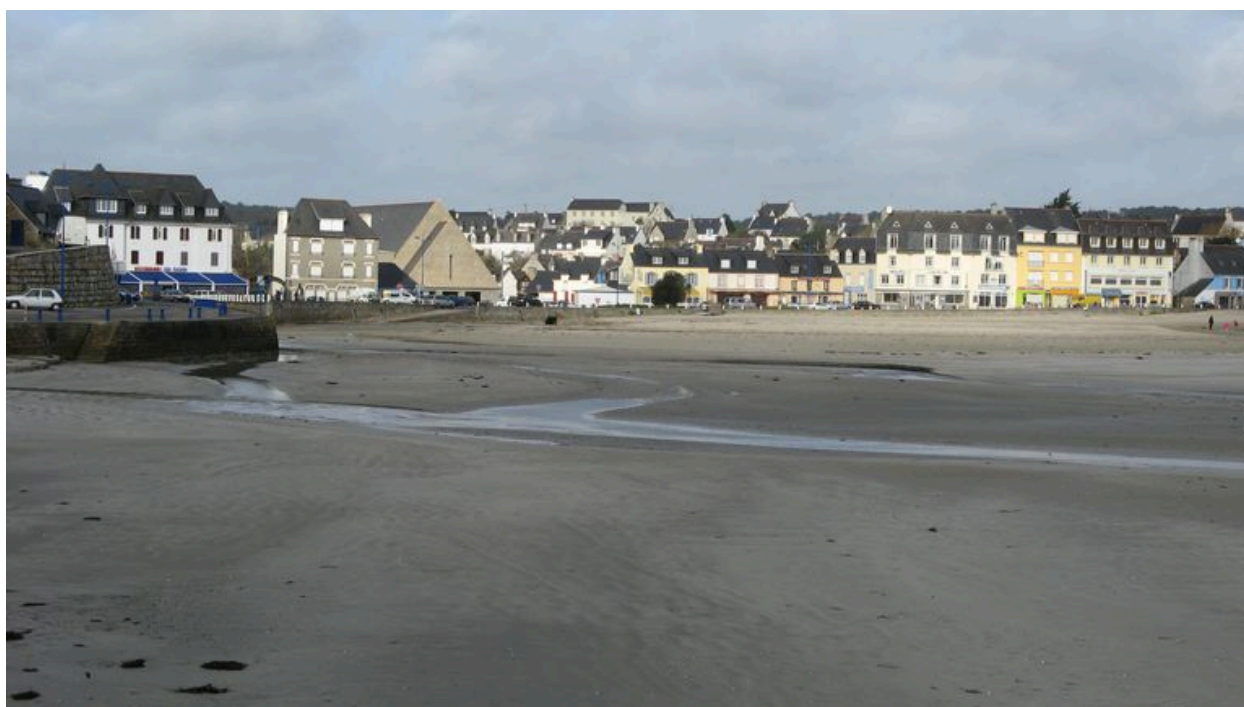
Vue générale du front portuaire de Morgat
