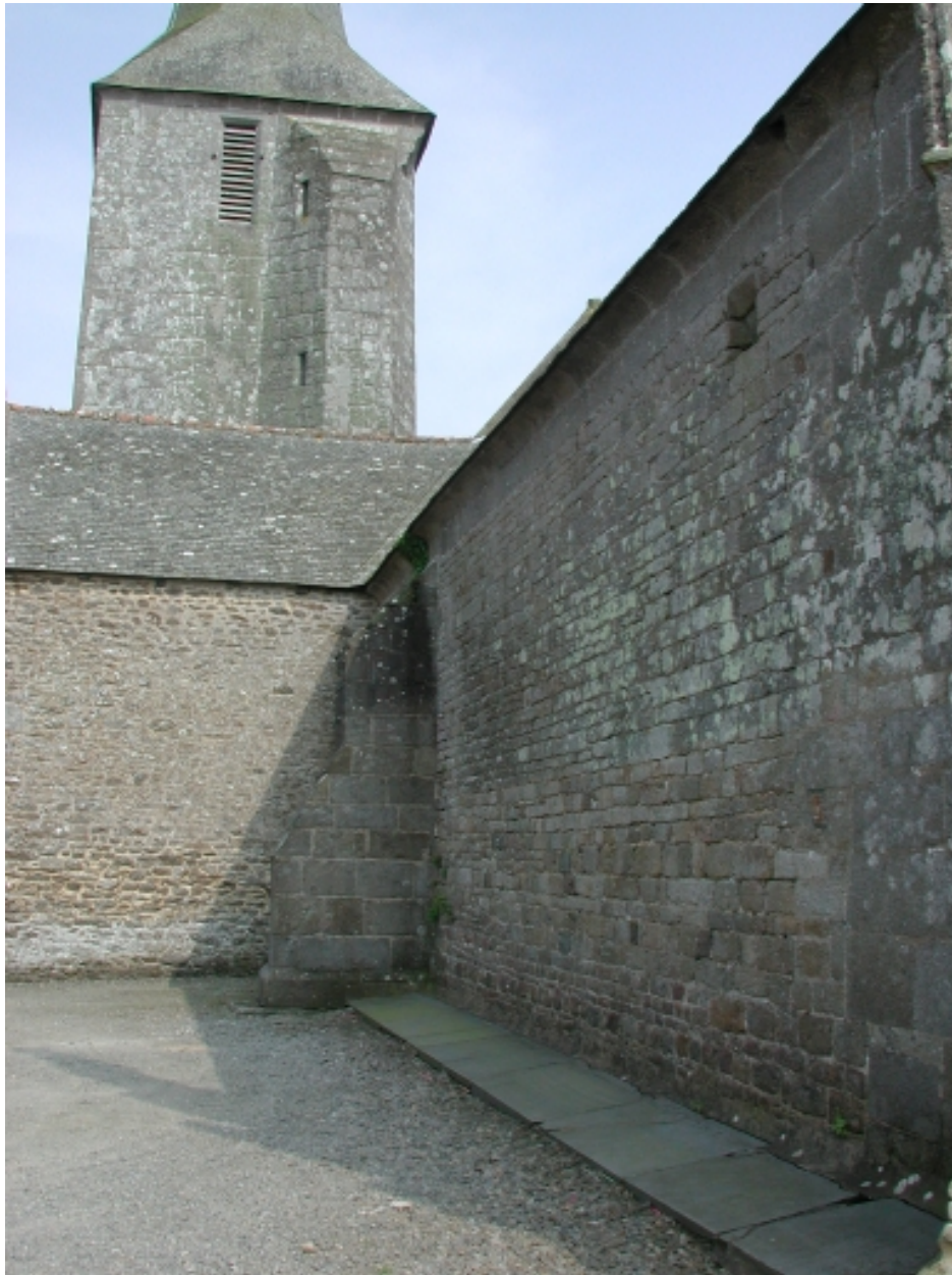
Vue partielle sud ouest
