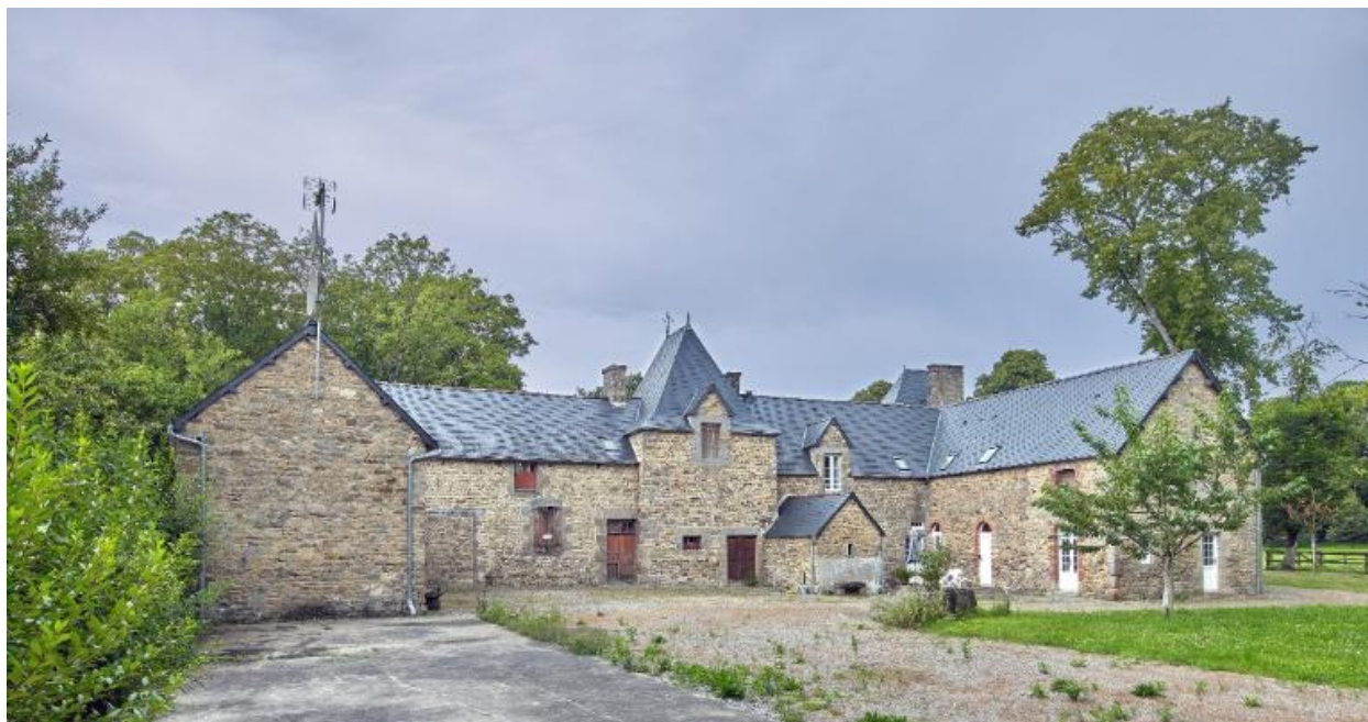
Dépendances du château : vue générale depuis l'est.
