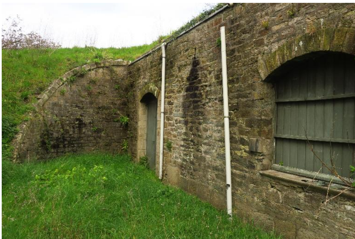
Le Palais, enceinte urbaine, réduit C, façade frontale.
