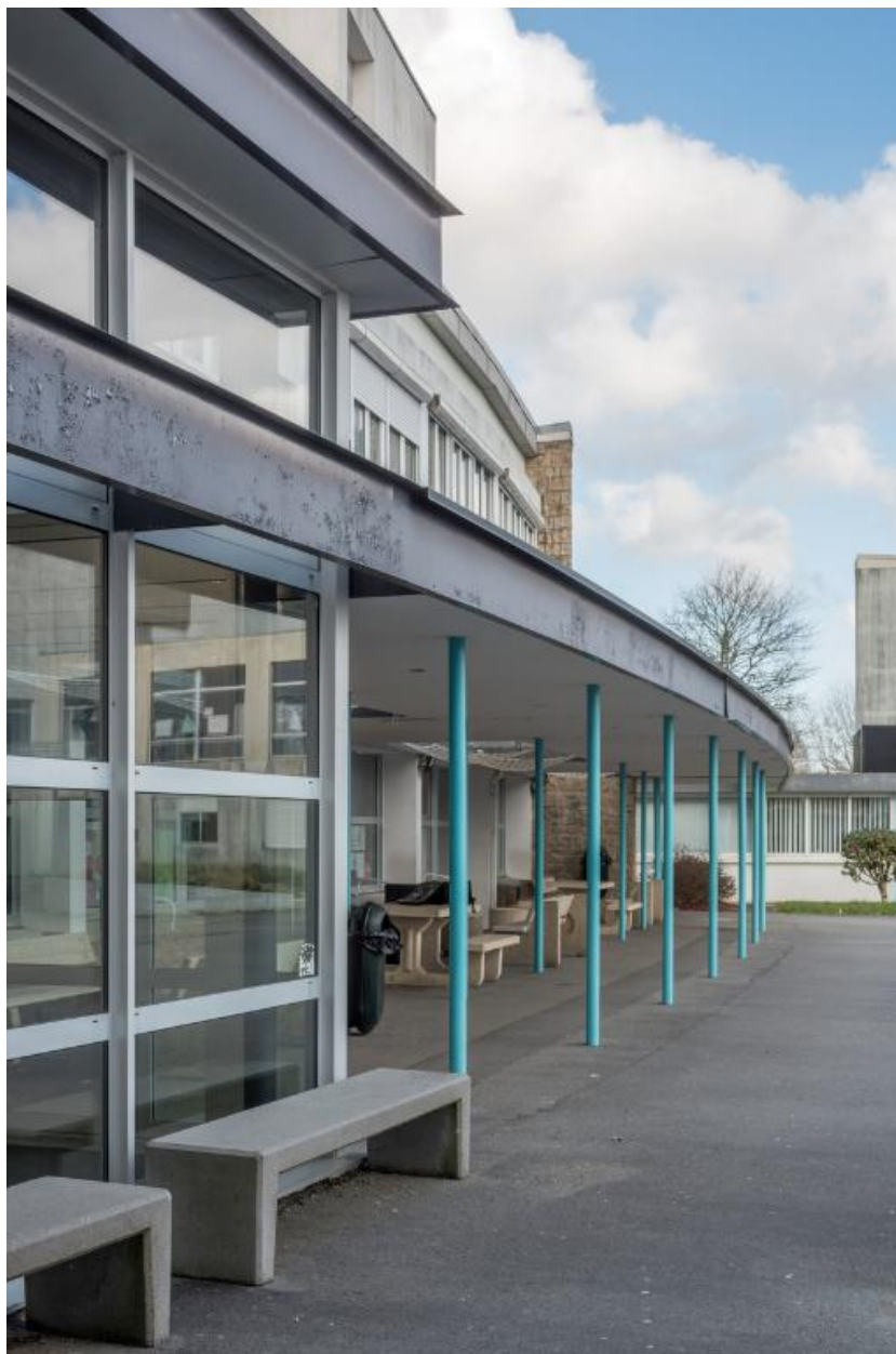
Galerie de circulation couverte devant la façade des anciens réfectoires. Raymond Lopez, architecte, 1958.
