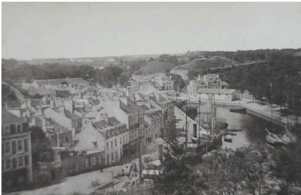
Le Palais, enceinte urbaine, ouvrage de Beausoleil, carte postale ancienne.
