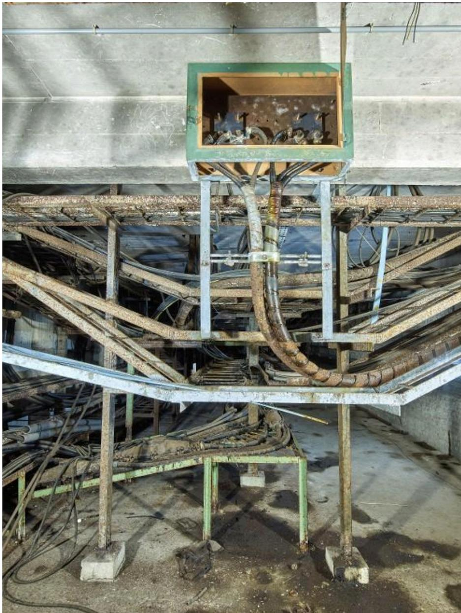
Vue du sous-sol de la centrale électrique : chemin de câble électrique sur plusieurs niveaux et boîtier de connexion. Poteaux, poutres et dalle de plancher sont en béton armé ; certaines poutres comportent des graffitis réalisés à la pointe
