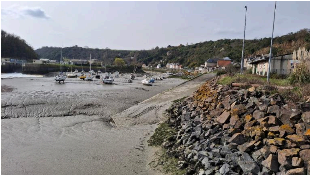
Cale et enrochement de la Ville-Gillette et zone de mouillage
