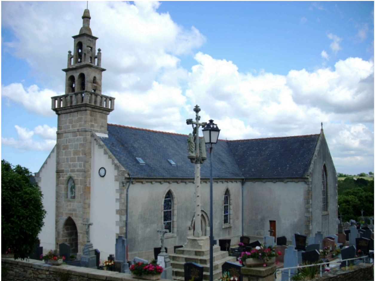
Tréglonou, église paroissiale : vue générale sud-ouest
