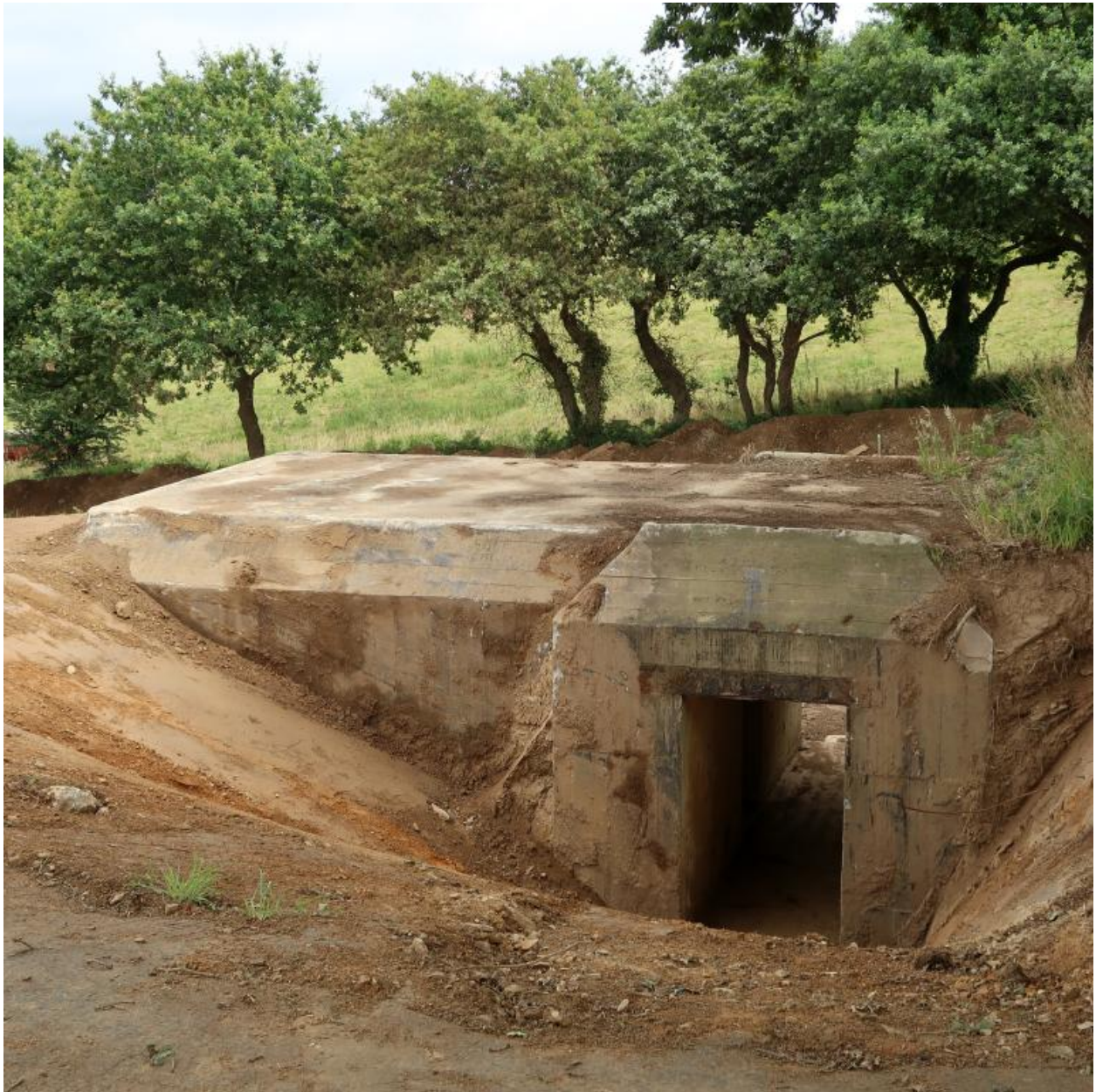
Vue générale depuis l'ouest (état en 2023)
