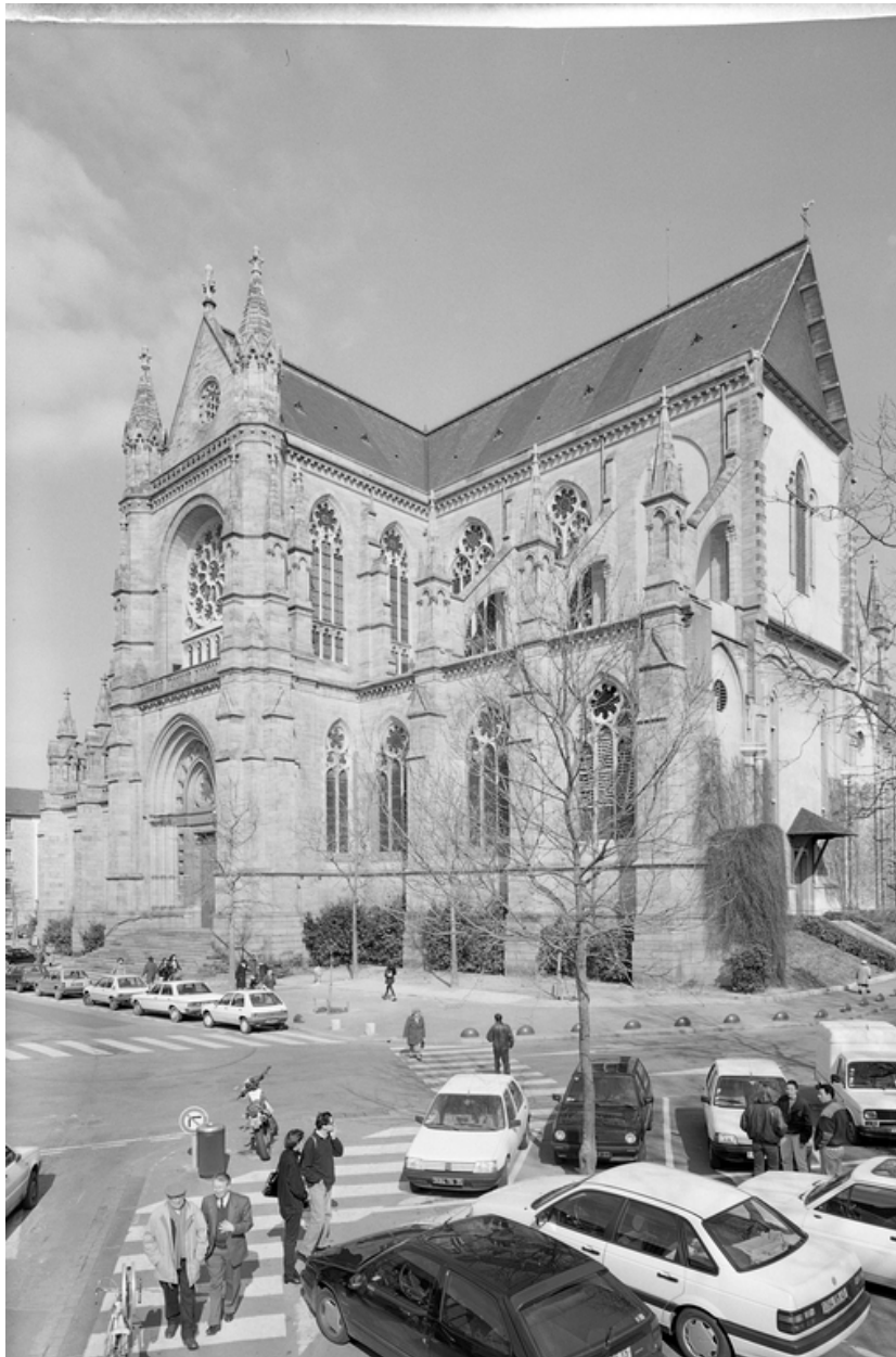
Elévation Sud-Ouest : vue générale.
