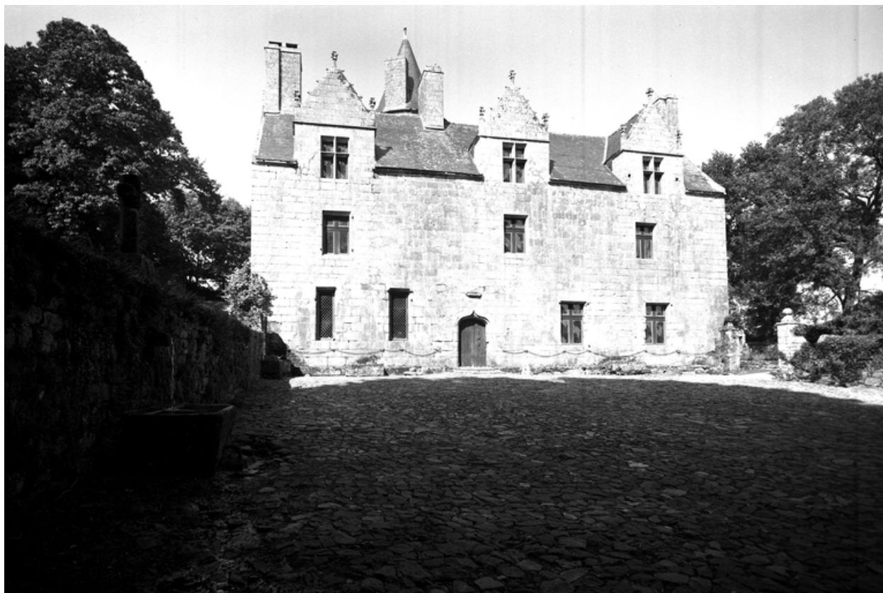
Logis : élévation antérieure
