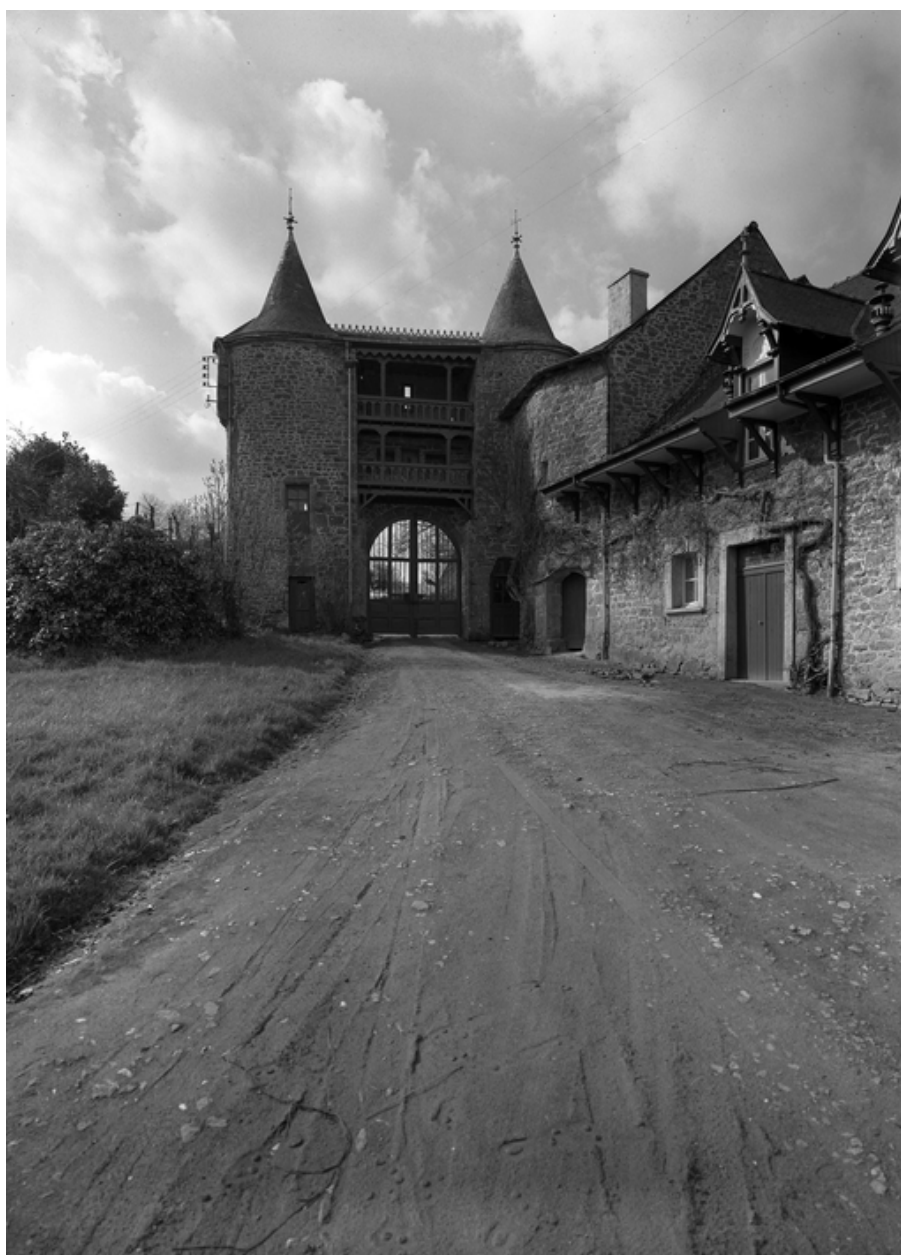
Châtelet d'entrée, façade nord, enquête de 1969
