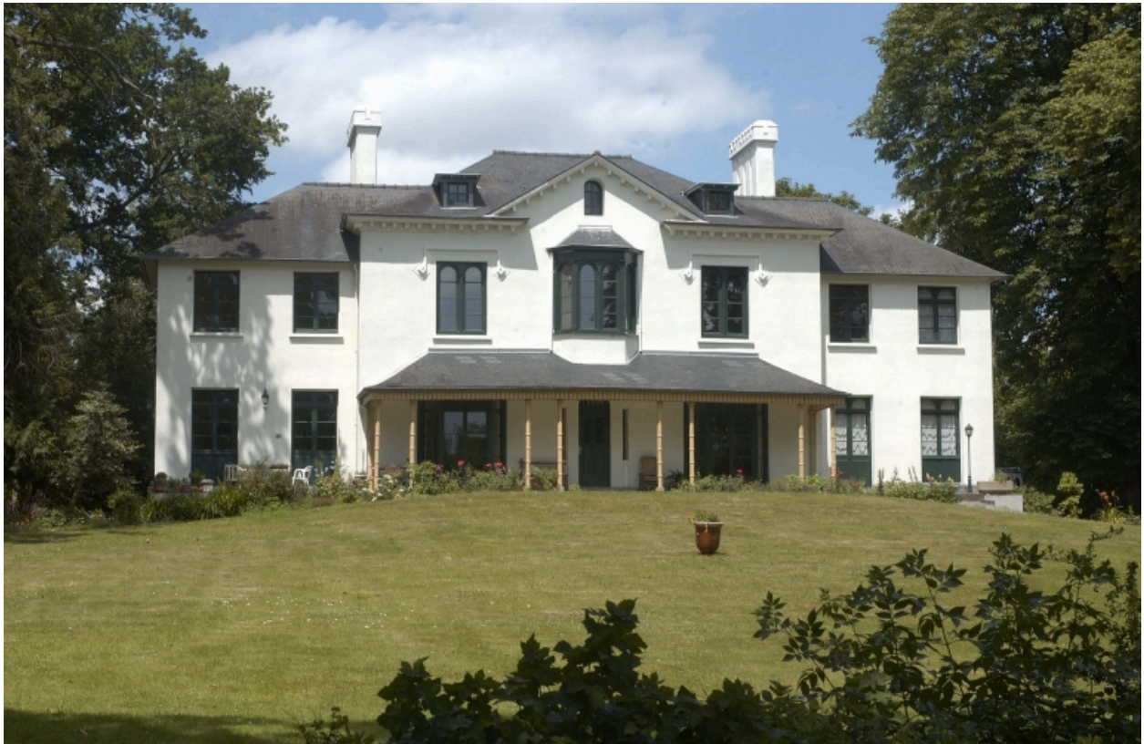
Vue générale de la façade sur jardin
