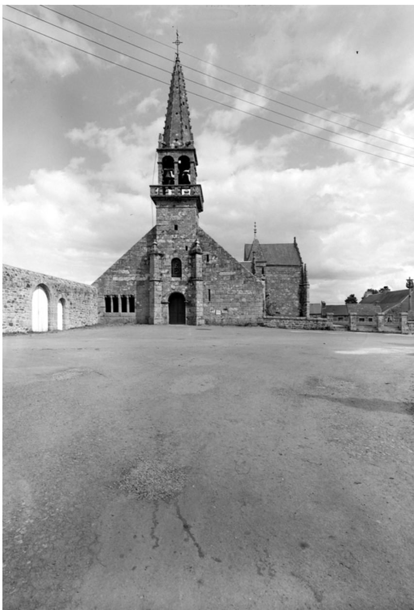
Vue générale de la façade ouest
