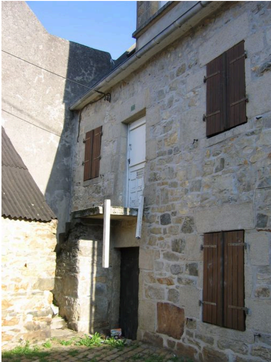
Maison au 9 rue de Bruxelles avec escalier extérieur
