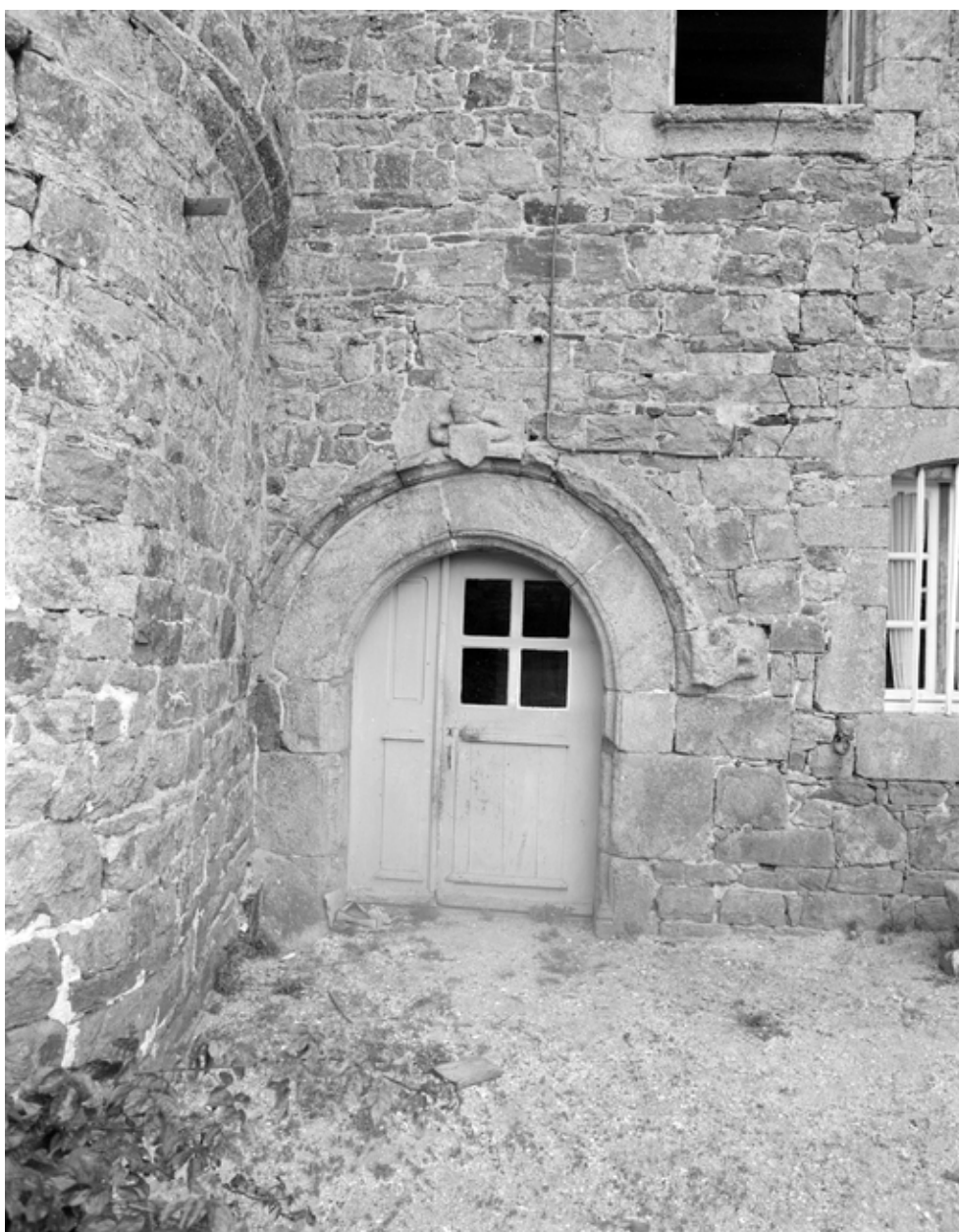
Détail de la porte
