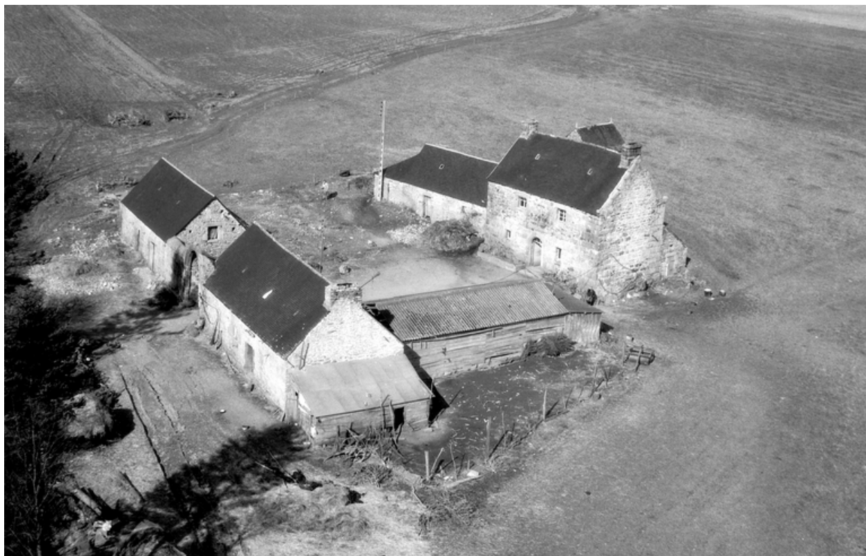
Vue aérienne prise du sud-est
