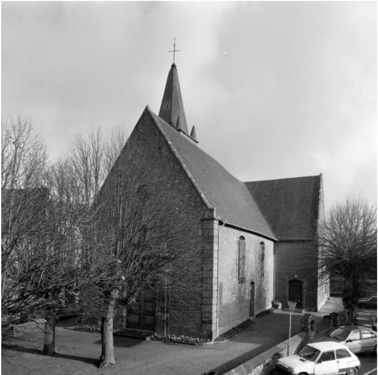
Elévation Sud-Ouest : vue générale
