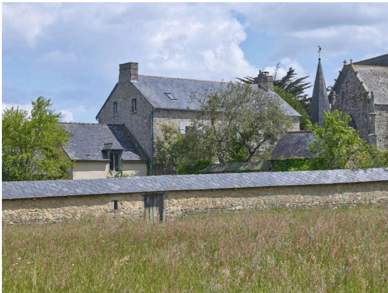
Vue ouest de l'ensemble
